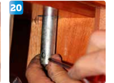
20 Det behövs en hylsa för att komma åt och gänga fast slangsockeln underifrån.
