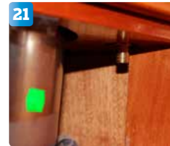
21 Slangsockeln sitter på plats under bänken.
