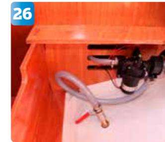
26 All slandragning är klar. Så här blev det färdiga resultatet. Kranens avstånd från tryckvattenpumpen är drygt en meter.
