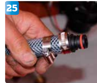
25 För att komma åt att rengöra filtret måste slangen från kulventilen dras bort. En snabbkoppling på slangen underlättar. Viktigt är att de två slangklämmorna alltid sitter med skruven på varsin sida om slangen för att förhindra läckage.
