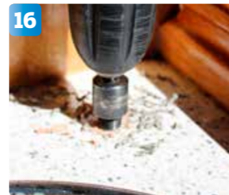
16 Dags att montera fast den nya sjövattnenkranen. Med hålsåg borrar ett hål med 17 millimeters diameter i den tjocka bänkskivan.
