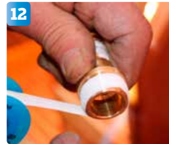
12 Gängtejp lindas också på slangsockeln som sedan ska gängas fast på kulventilen.
