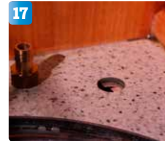
17 Intill hålet syns en liten mässings-slangsockel som ska dra fast blandaren underifrån.
