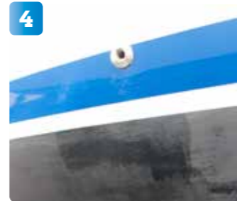
4 Den nya genomföringen placeras nedanför den befintliga genomföringen där vatten från diskhon rinner ut.
